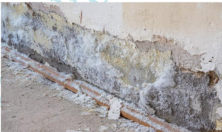
Bildexempel: Kapillär uppsugning med saltutfällning i källarvägg, ett vanligt fenomen i äldre murverk.
